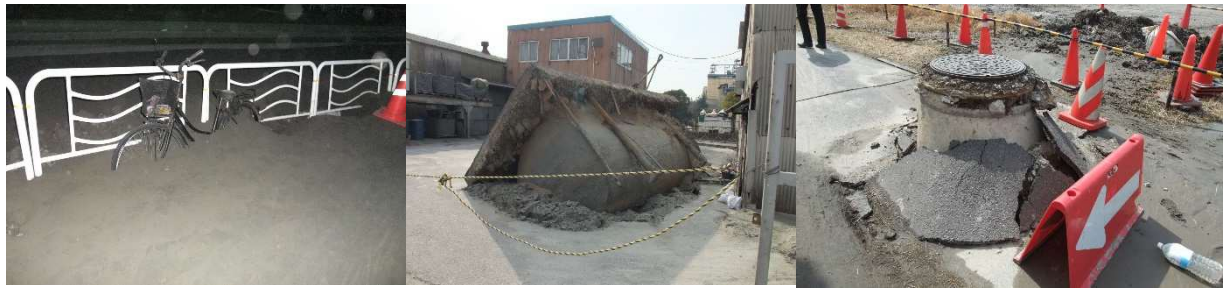
写真-1 東京湾沿岸での液状化被害
